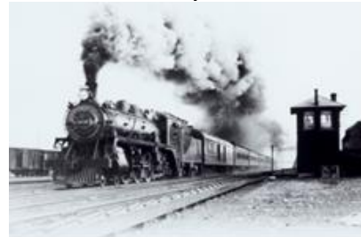
La locomotive à vapeur
